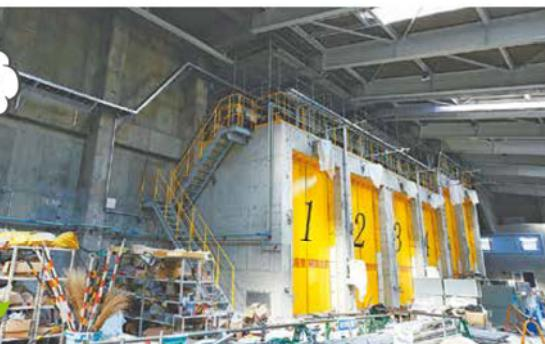
30年前に建てられた富田工場。黒ずんだコンクリートの壁はそのまま生かし、新しい「投入扉」を設けてごみ収集車を再び迎え入れます
