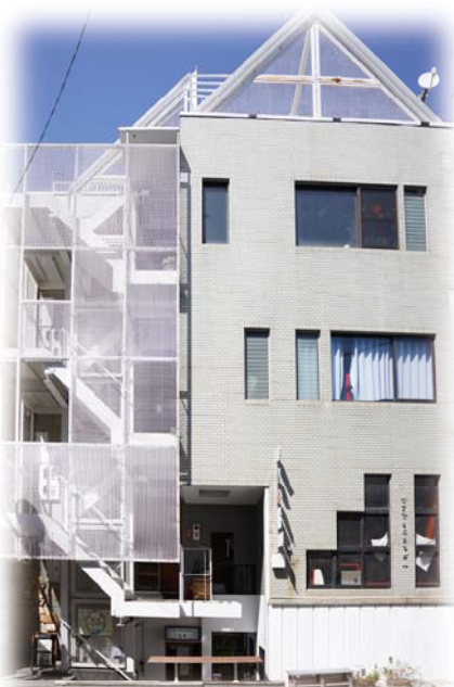
バーやスナックがあった雑居ビルを改装して、まちづくりの拠点として生まれ変わった「かさでらのまちビル」
