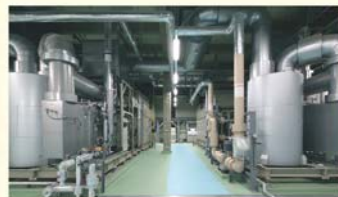
センター2階にあるガスコージェネレーション設備(上)と屋外にある大型の蓄電池(下)※
