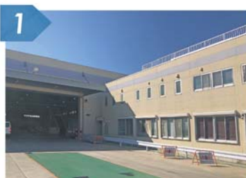
リサイクルセンター前の地面が緑の部分は、運んできた資源の重さを量れるトラックスケール。ここにトラックが乗ると重さを計量できます。
