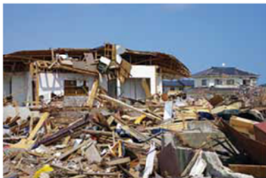
東日本震災で倒壊した家屋
