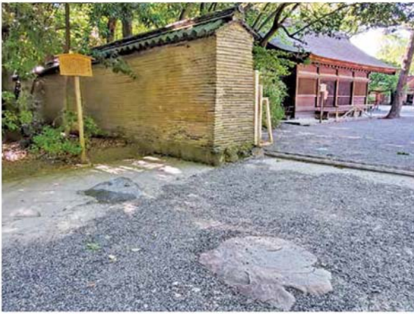
全長400m、瓦を厚く積み重ねて作られた日本三大土塀の一つ信長塀(中央・奥)。手前側と奥側にある石が海蔵門(かいぞうもん)の礎石だ
